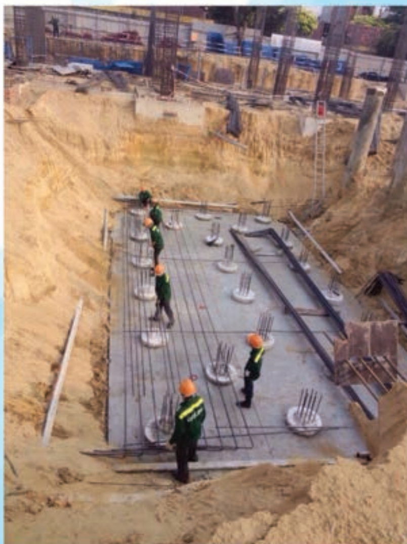
Thi công móng M6
