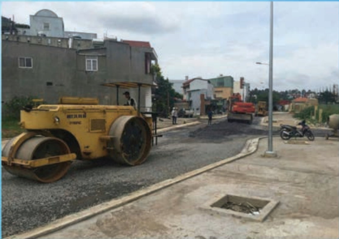
Thi công kết cấu đá lớp 3 Aggregate - Layer 3
