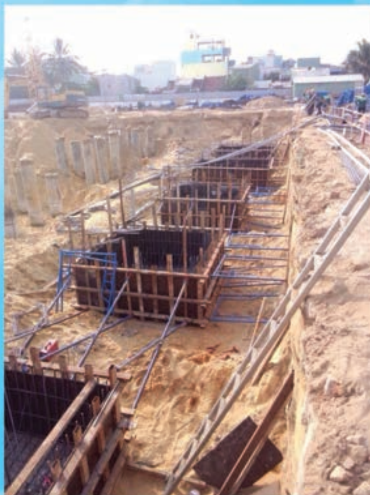
Thi công móng M2
