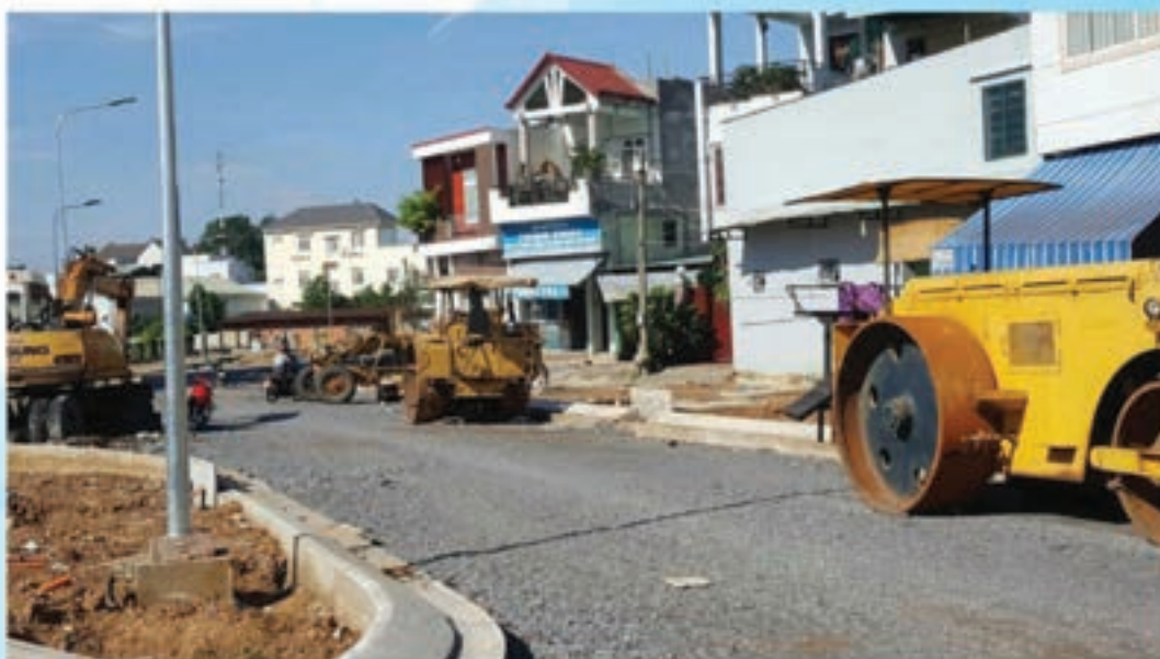
Thi công kết cấu đá lớp 2 Aggregate - Layer 2
