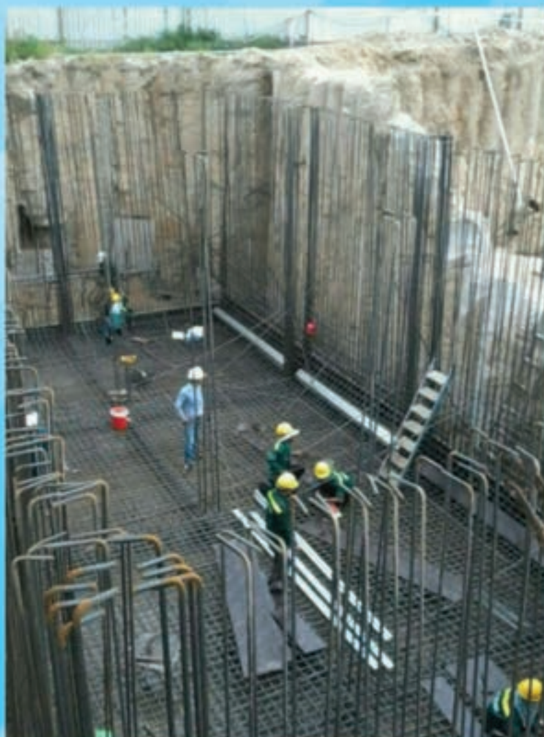
Thi công móng tầng hầm
